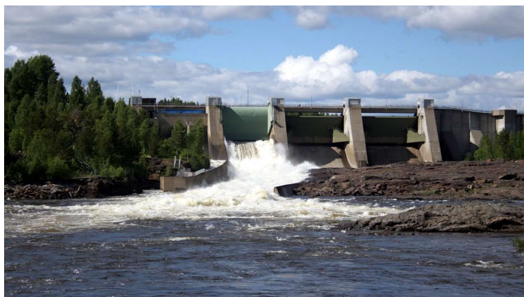
Rootsi üks suuremaid hüdroelektrijaamu Stornorrfors
